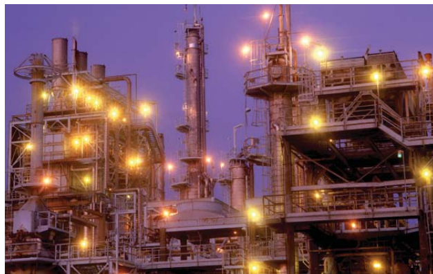
Bild 1: Zustandsüberwachung gewinnt in der Anlagentechnik immer größere Bedeutung.
